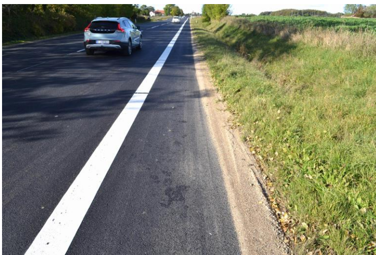
Nyopstribet cykelbane på Omfartsvejen. Bredden varierer fra 80 til 140 cm. Det vil være godt med en smal højre stribe til mørkekørsel.
