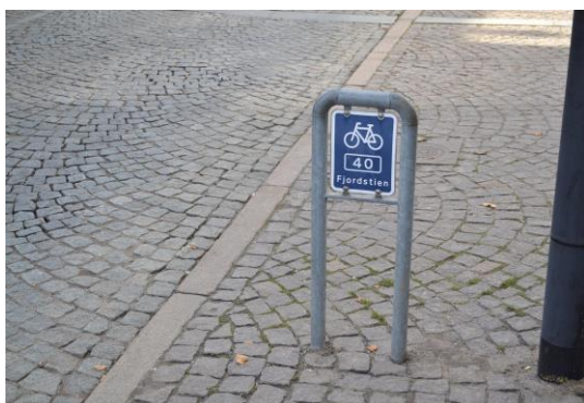
Chaussessten bør være jævne, dvs. skårne.
